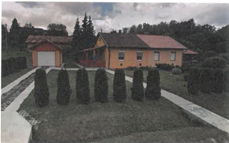
a Maort telep egykori munkáslakásainak jellemző épülettípusa
