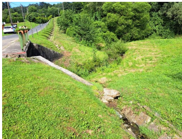
4. Béke úti híd
