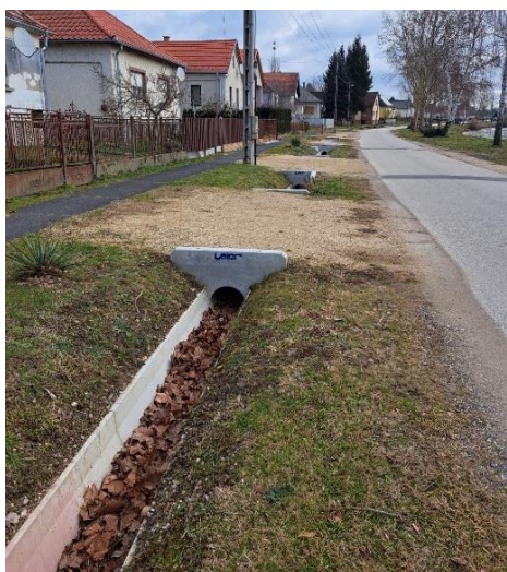
Fő utcai felújított árok
