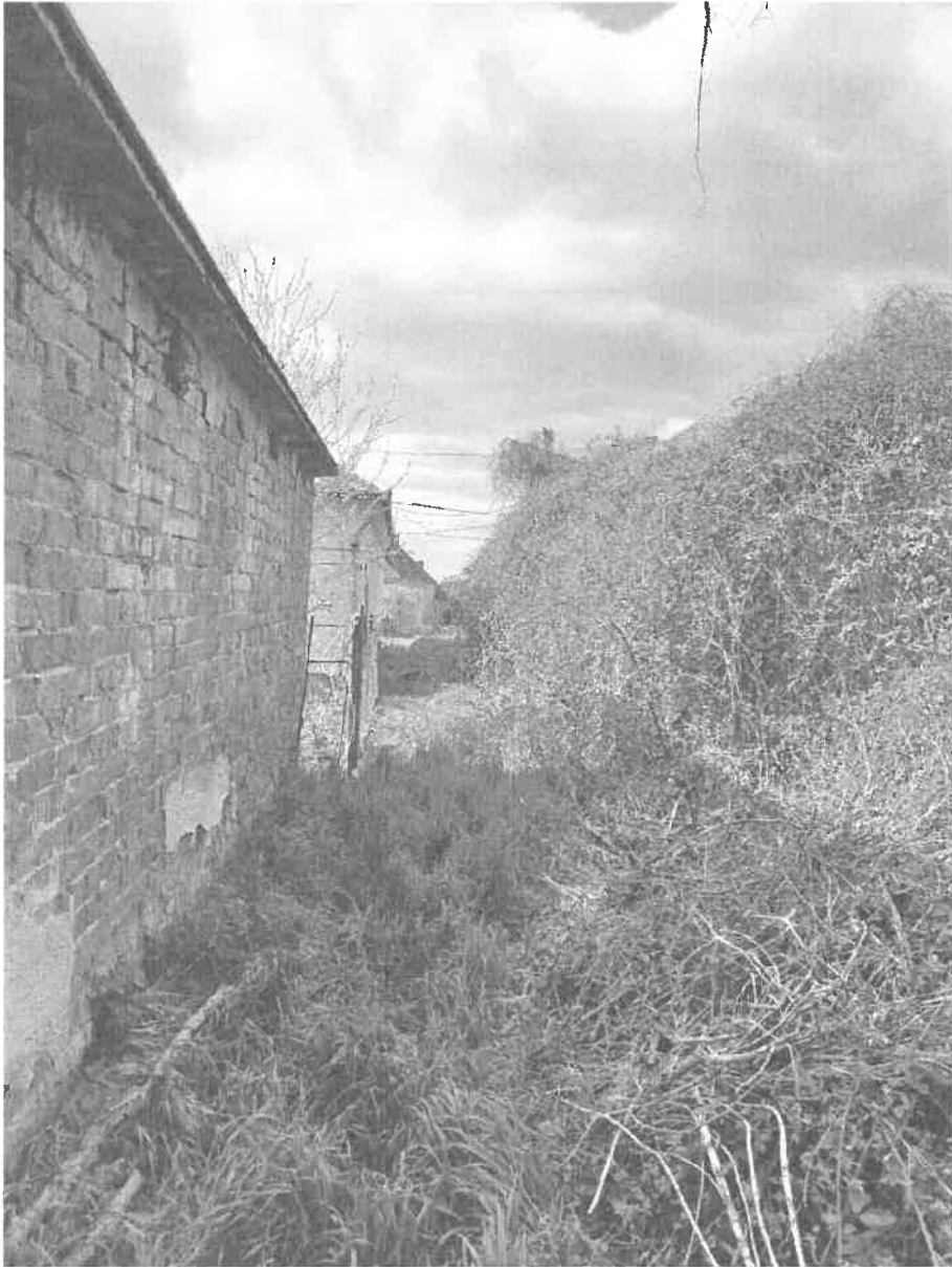
Csörnyeföld, Dózsa út 37.
