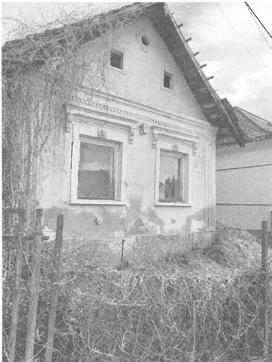
Csörnyeföld, Dózsa út 37.
