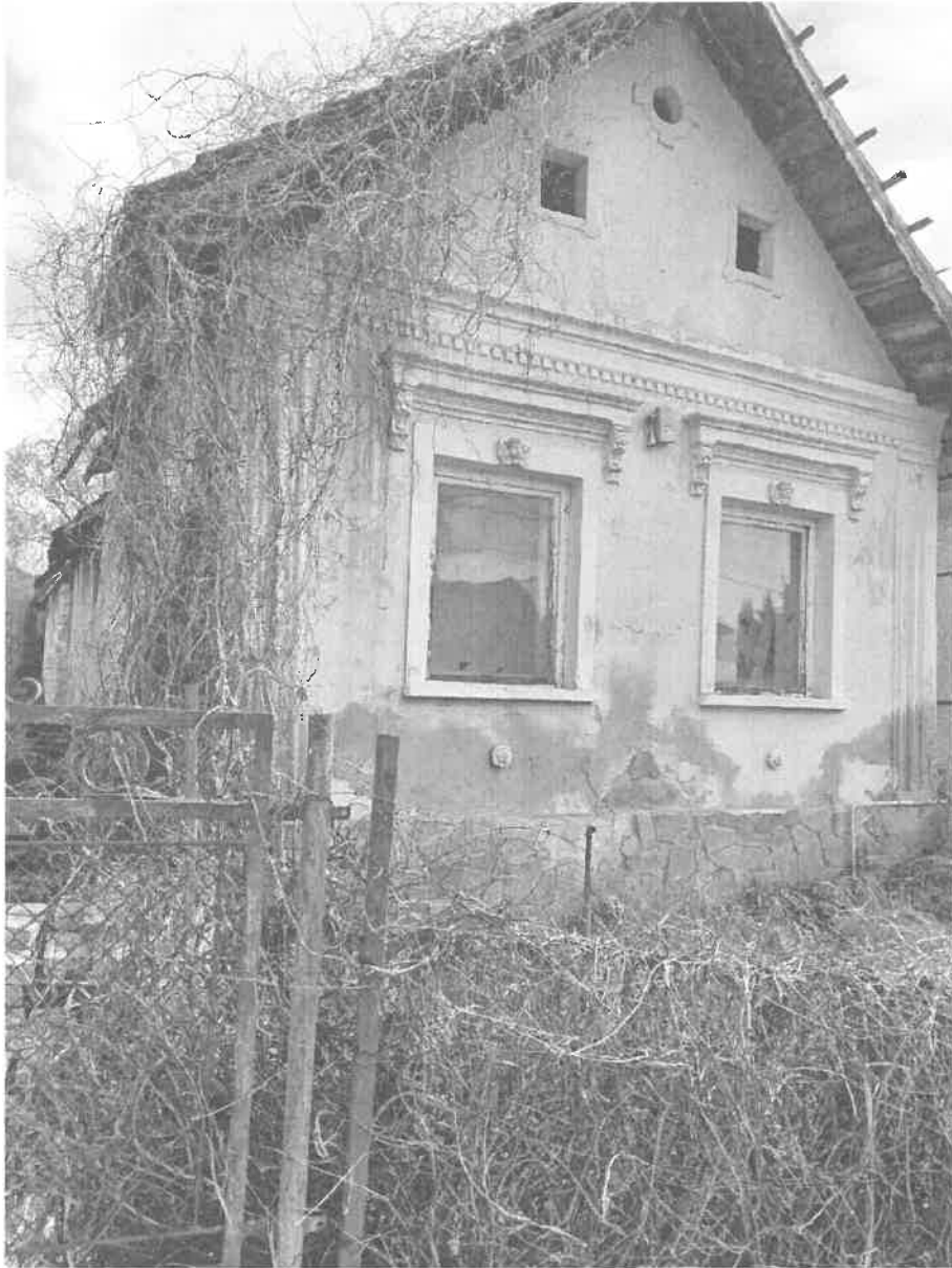
Csörnyeföld, Dózsa út 37.
