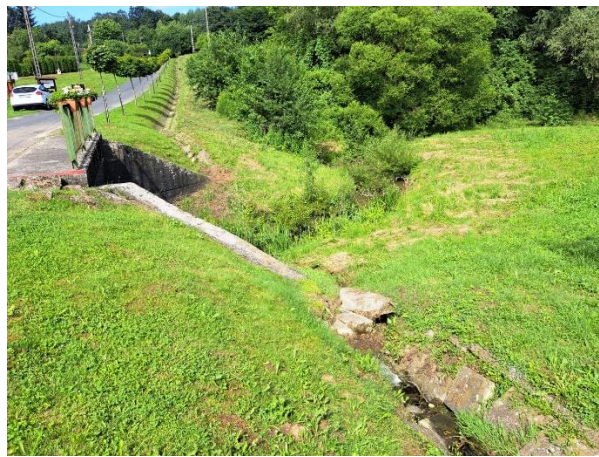
4. Béke úti híd
